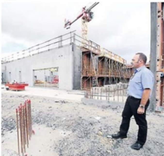
Le directeur de l'Enit est satisfait de l'avancée des travaux. / Photo DOM, Laurent Dard.
